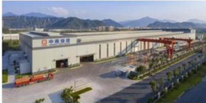
富阳区生产基地
